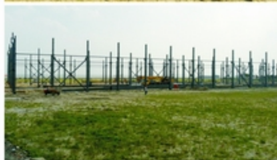
Pc工程工地
