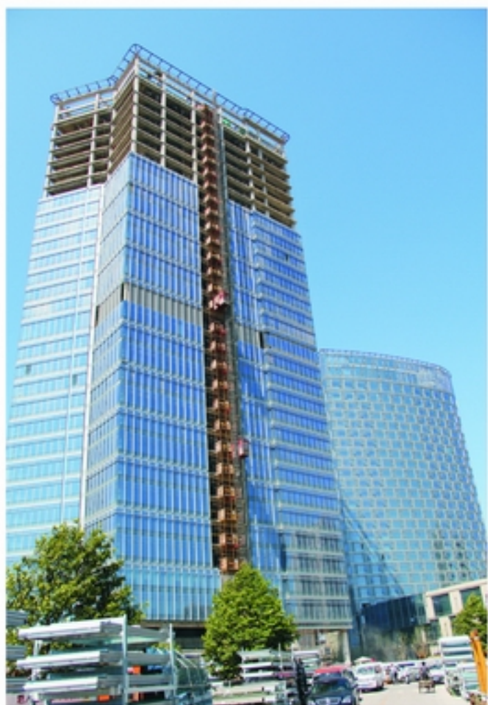
苏州晋合广场正在安装幕墙和绿化
